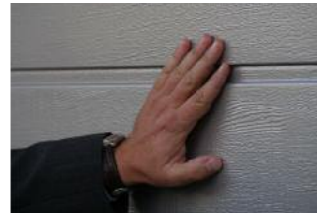
Garagen-Sectionaltore sollten über einen Fingerklemmschutz (hier im Bild) verfügen, damit die Finger beim Schließen des Tores nicht zwischen den einzelnen Tor-Sectionen eingequetscht werden können.
