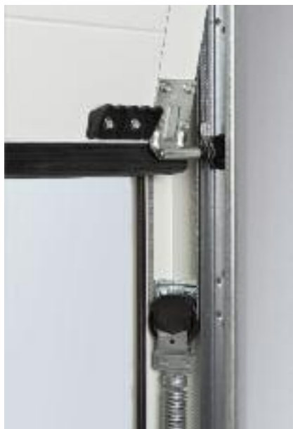
Das Feder-in-Feder-System an den Seiten des neuen Garagentores (Bild unten) sorgt dafür, dass beim Brechen einer Feder eine weitere das Tor hält. Oben im Bild ist eine alte Feder zu sehen. Bricht diese, kann sie durch die Luft fliegen. Außerdem besteht die Gefahr, dass das Tor dann abstürzt.
